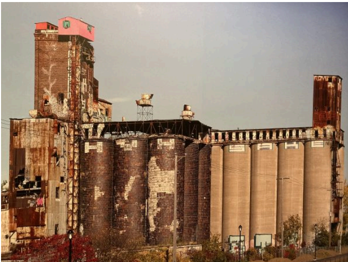
Les silos en ruines de l'usine de la Canada Malting, rue Saint-Ambroise. Photo: Claude Deschênes
